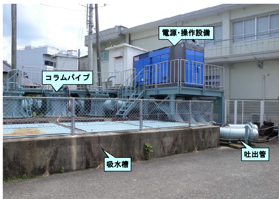
排水機場全景
