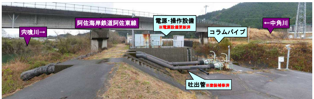
排水機場全景
